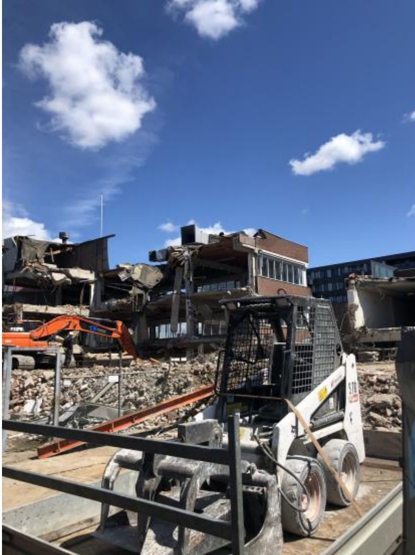
Foto: De start van de sloop van het V&D gebouw en De Deining aan het Dik Tromplein.
