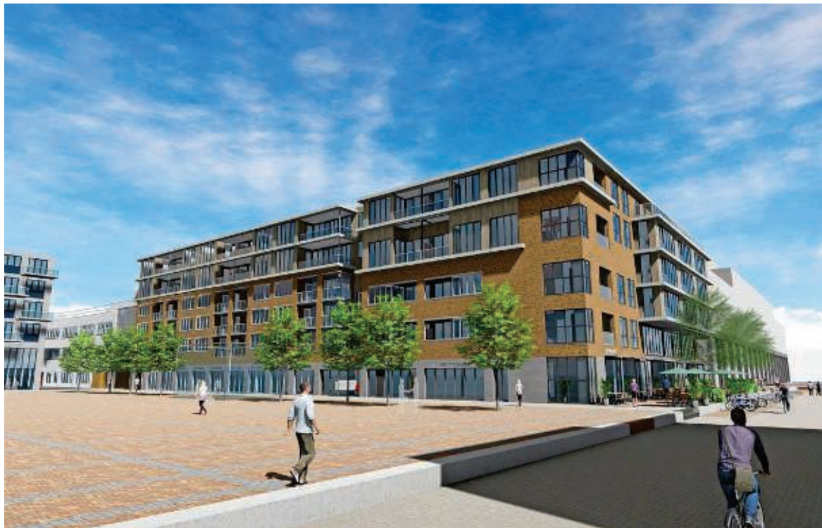
Woongebouw Parelhof wordt opgehoogd met appartementen.
