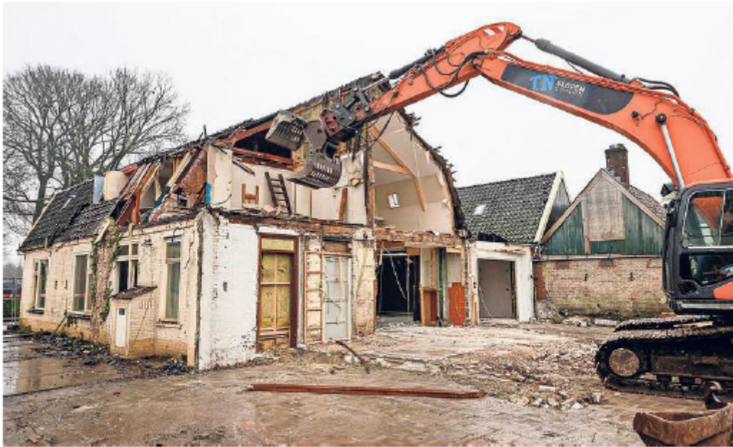
Aan de Breestraat 22 zijn de sloopwerkzaamheden in volle gang.
